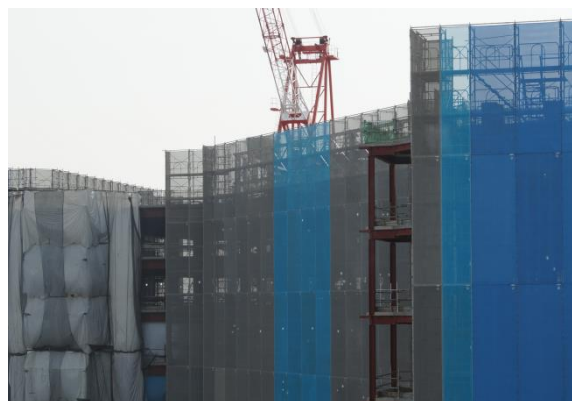
▲ 5階から9階部分（施工予定）
